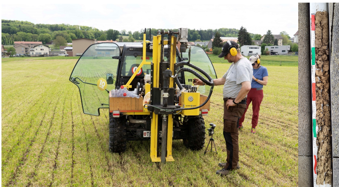
Figure 24 : Tour de carottage Wintex MCL3 (à gauche) et sondage réalisé (à droite)
